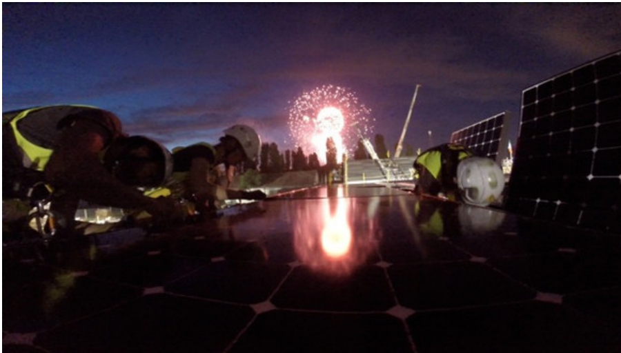
Die Photovoltaikmodule montierte das Team bei Nacht und Feuerwerk.
